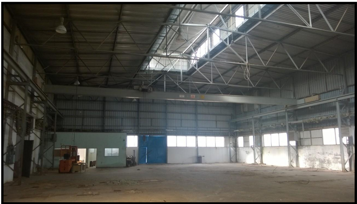
Slika 3 Unutrašnjost postojeće hale
